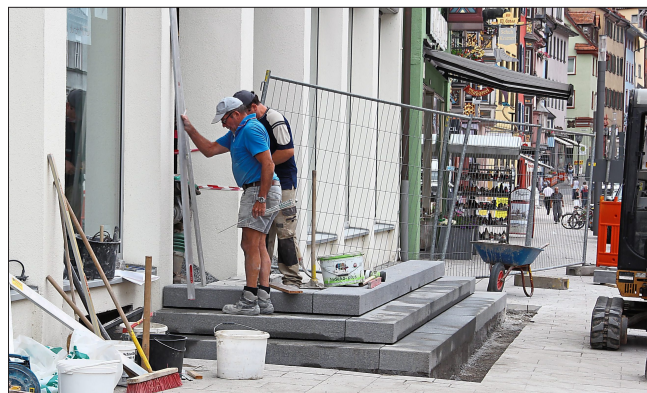
Vor zwei Modengeschäften in der Hochbrücktorstraße wird eine Rampe mit Treppenstufen gebaut.
