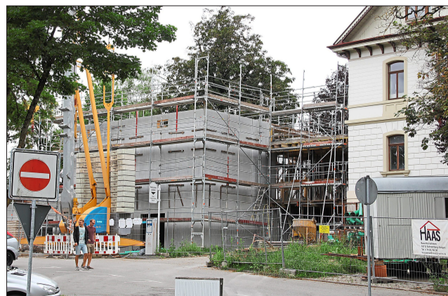
Weitere Betonelemente werden an den Anbau der Villa Duttenhofer angebracht. Fotos: Schulz
